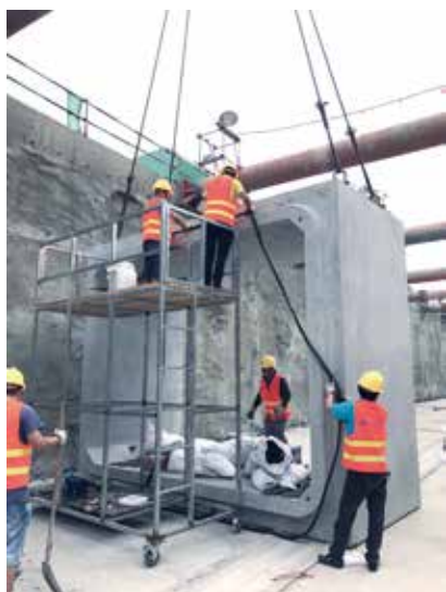
图2 预制管廊插口楔形胶圈安装效果图
