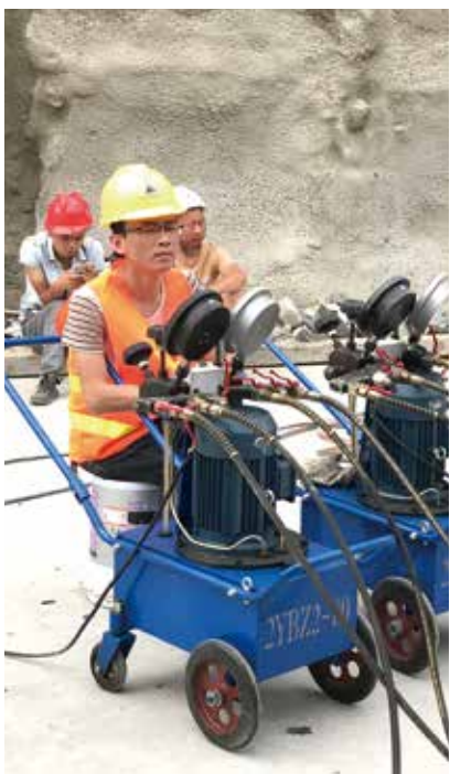
图7 预制管廊张拉效果图
