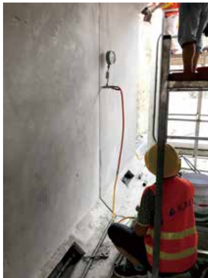
图8 预制管廊接缝处闭水试验效果图
