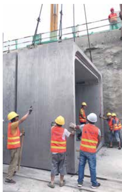
图6 预制管廊拼装效果图
