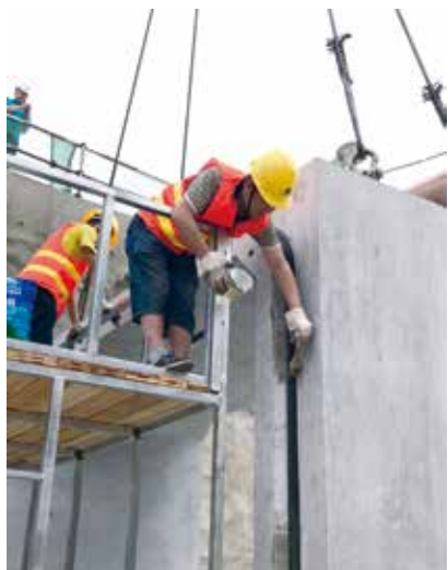
图3 预制管廊插口面涂刷酚醛粘结剂效果图
