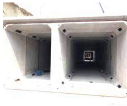
图 10 预制综合管廊安装效果图一
