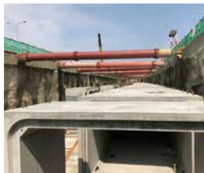
图 11 预制综合管廊安装全景图二
