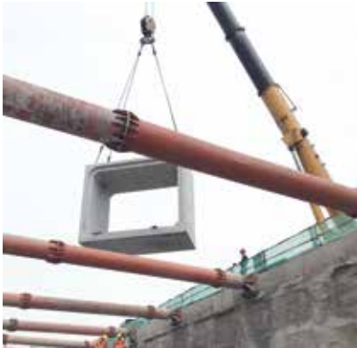
图 1 预制管廊吊装效果图
