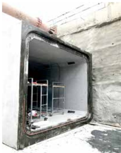
图4 预制管廊承口面涂刷酚醛粘结剂
