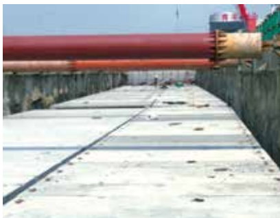
图9 预制管廊外部密封胶封闭效果图
